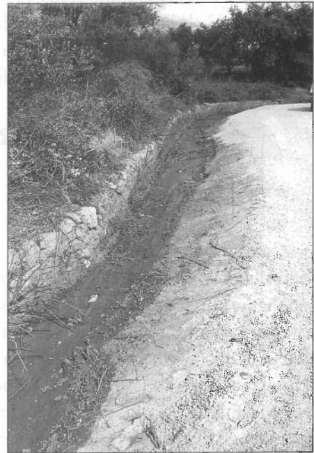
Cuneta per el desguàs de l'aigua
