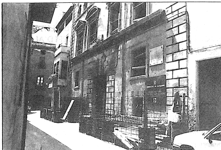
Obres a Ca Cosme
