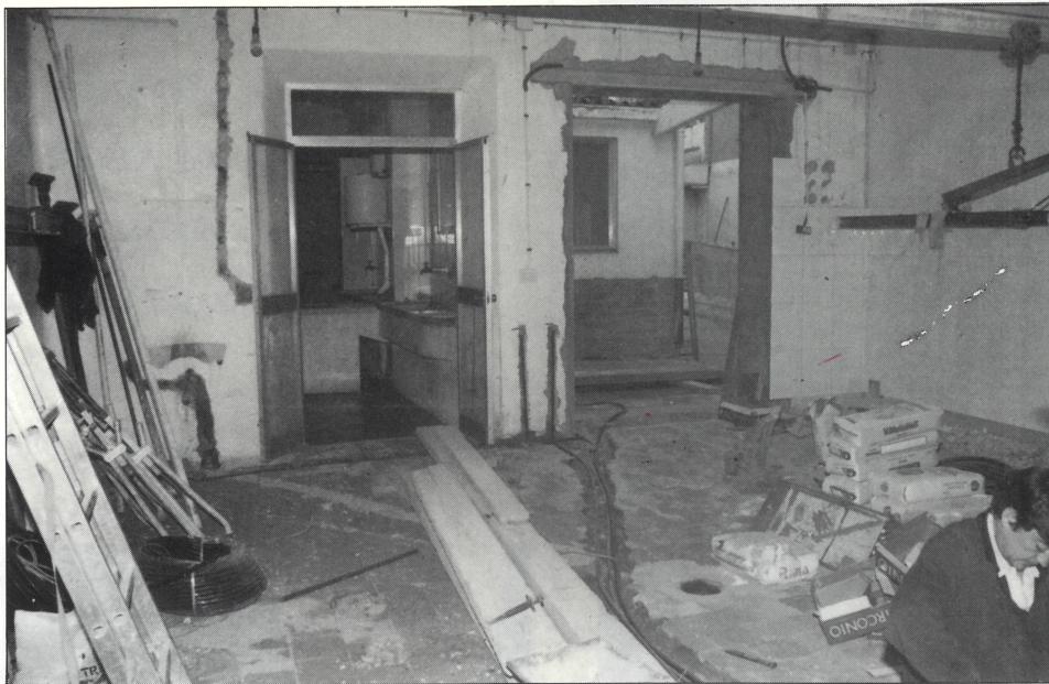
Obres a l'interior de l'escorxador
