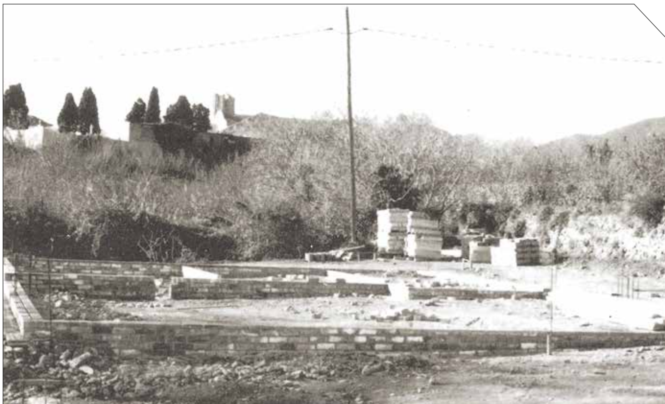
Fotografia inici d'obres del Parc de Bombers d'Alcover - Any 1991
