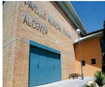
INSTAL·LACIÓ DE PORTES D'EMERGÈNCIA AL PAVELLÓ MUNICIPAL
