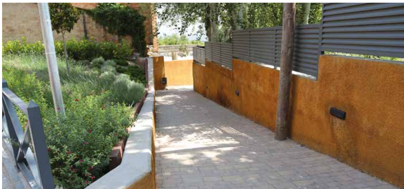
MILLORA DE L'ACCÉS PEATONAL DE L'APARCAMENT DE LA FIRA
