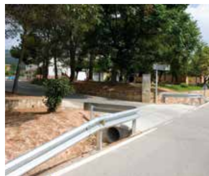
MILLORA DEL FERM AMB LA ELIMINACIÓ DELS SALTS AL CAMÍ COMTE DE PRADES
