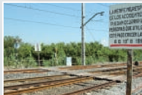
Pas a nivell del carrer Pintor Català
