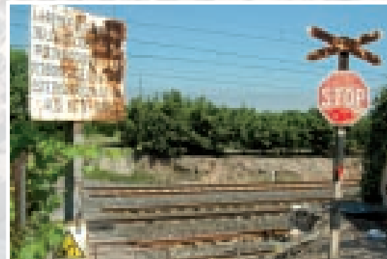
Pas a nivell del carrer de la Unió
